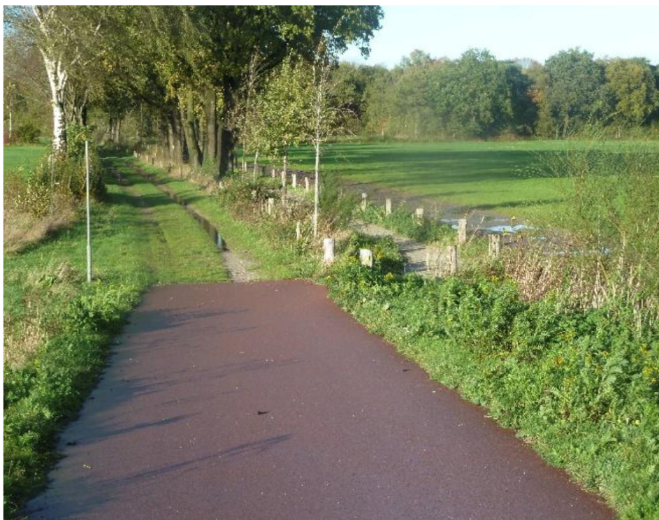
Waar is het fietspad? Op-en Afrit Fietsbrug
