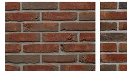
Steenkeuze: bijv. Wienerberger Bassl Wienerberger Elsterbond handvorm Metselverband: staandverband
