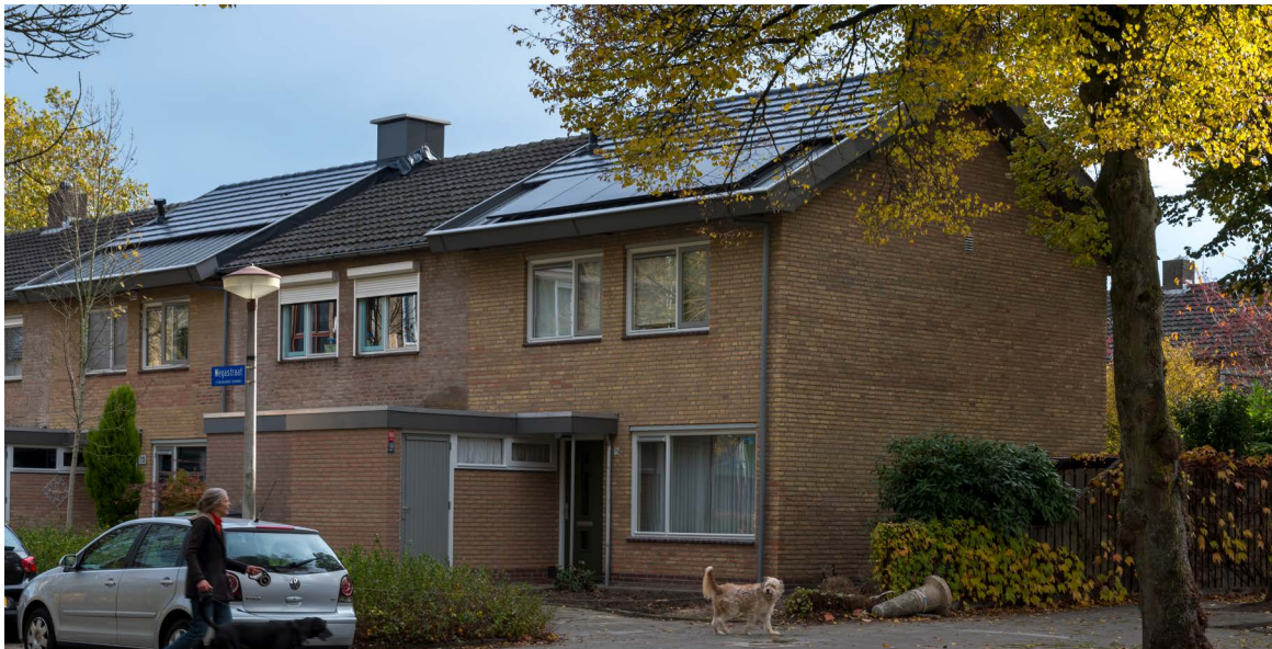
Woonbedrijf plaatste zonnepanelen op huurwoningen in Vaartbroek
