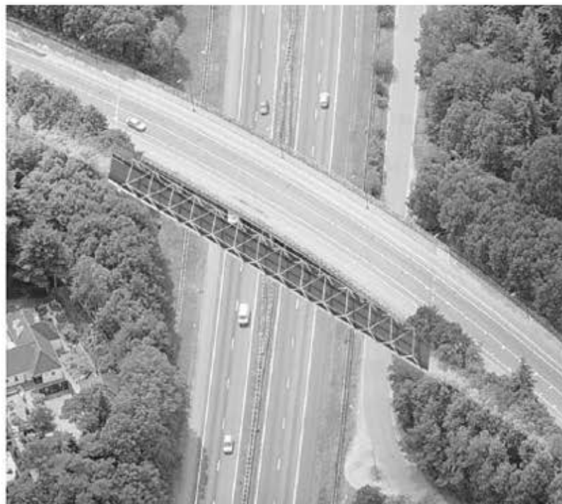
Nieuwe fietsbrug over de A67 richting de Kempen
