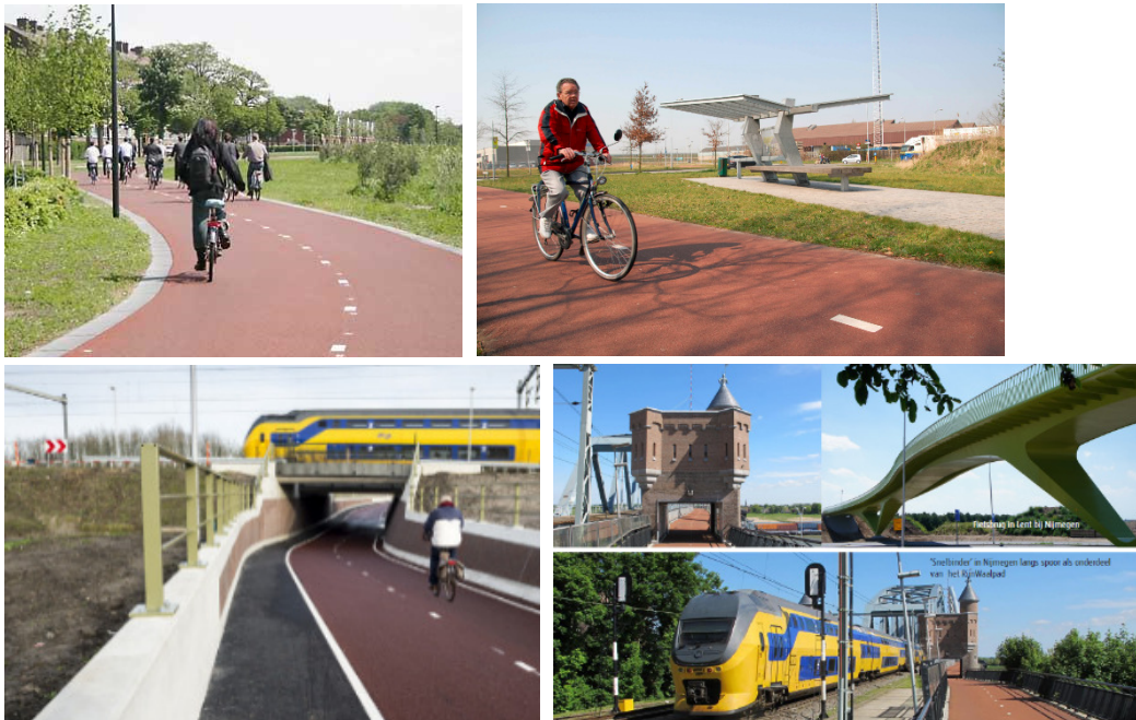
Figuur B1.7: referentiebeelden snelfietsroutes (Breda - Ettenleur, Rijnwaalpad, F35 Twente en Lunetten - Uithof Utrecht).
