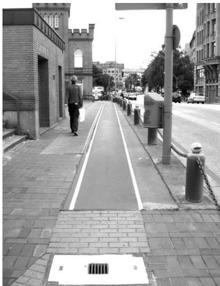
Fietspad houdt plotseling op
