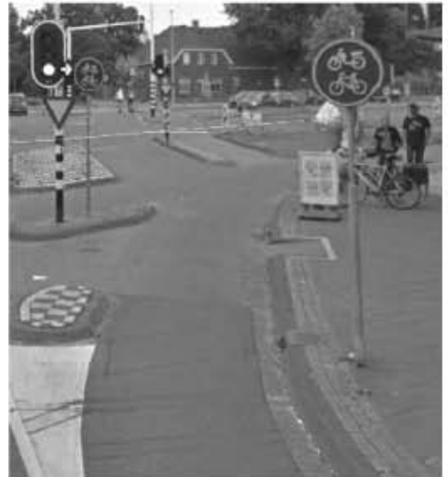
Waarom de geleider met het verkeerslicht rechts niet een halve meter ingekort?
