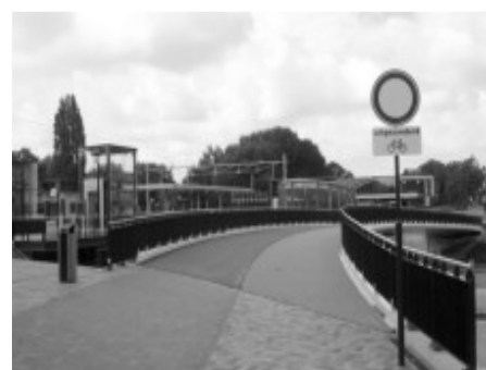
De brug naar de fietsenstalling
