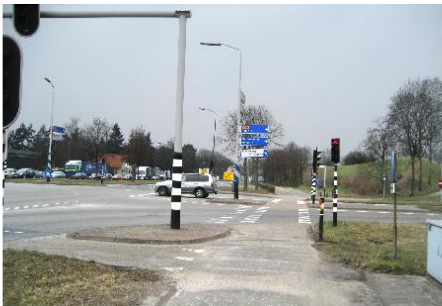
De oost-westverbinding door Helmond, Europaweg-Kasteeltraverse-Deurneseweg, telt zeventien verkeerslichtinstallaties
