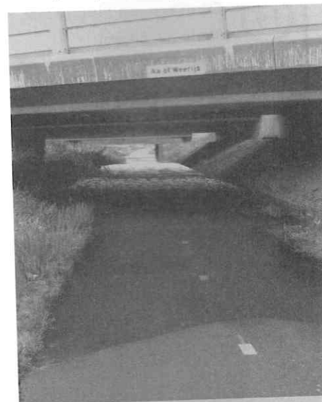
Fietspad onder snelweg Breda-Rijswijk
