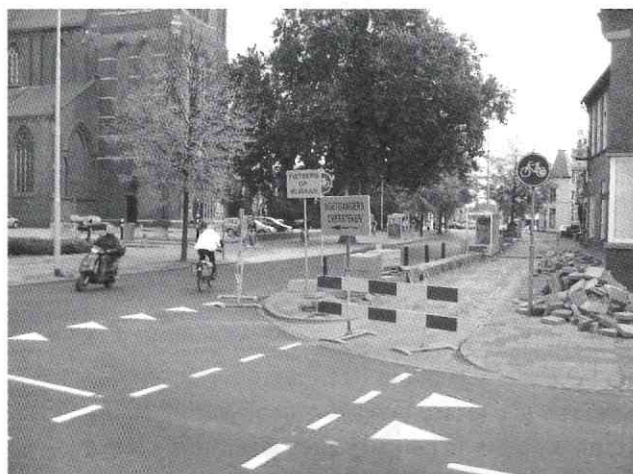
Herbestratingwerkzaamheden op de Kloosterdreef
