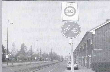
Het fietspad loopt gewoon door...
