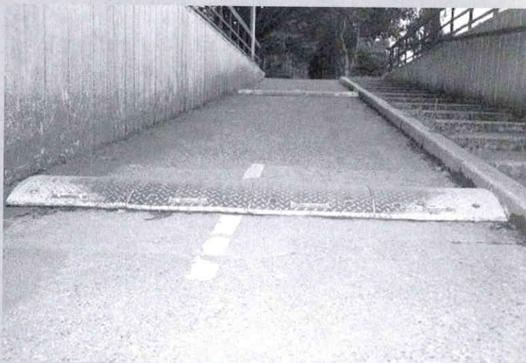
Fietsdrempel in stationstunnel
