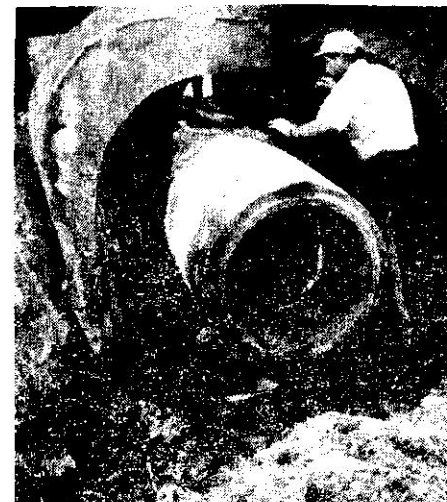
Een duiker moet zorgen voor de afvoer van slootwater.
